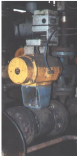
Bild 7: Keramikkugelhahn im Stahlwerk
