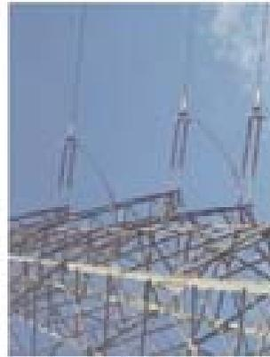
Langstabilisatoren in Hochspannungsfreileitungen
