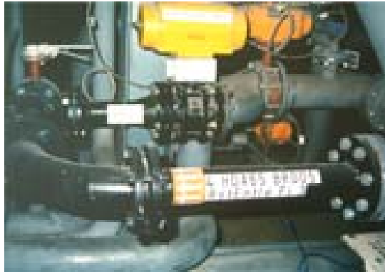
Bild 13: Komplette keramisch ausgekleidetes Rohrsystem DN 50 – DN 80, PN 16
