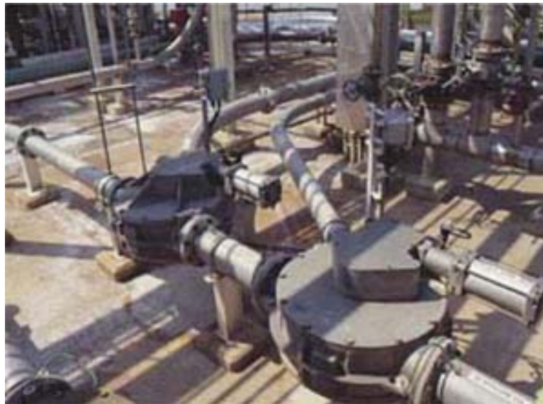
Bild 34: Pneumatisches Fördersystem
