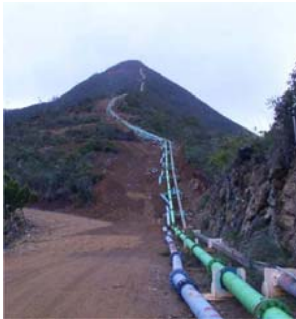
Bild 3: Rohrleitung zum Transport von Nickelerz
