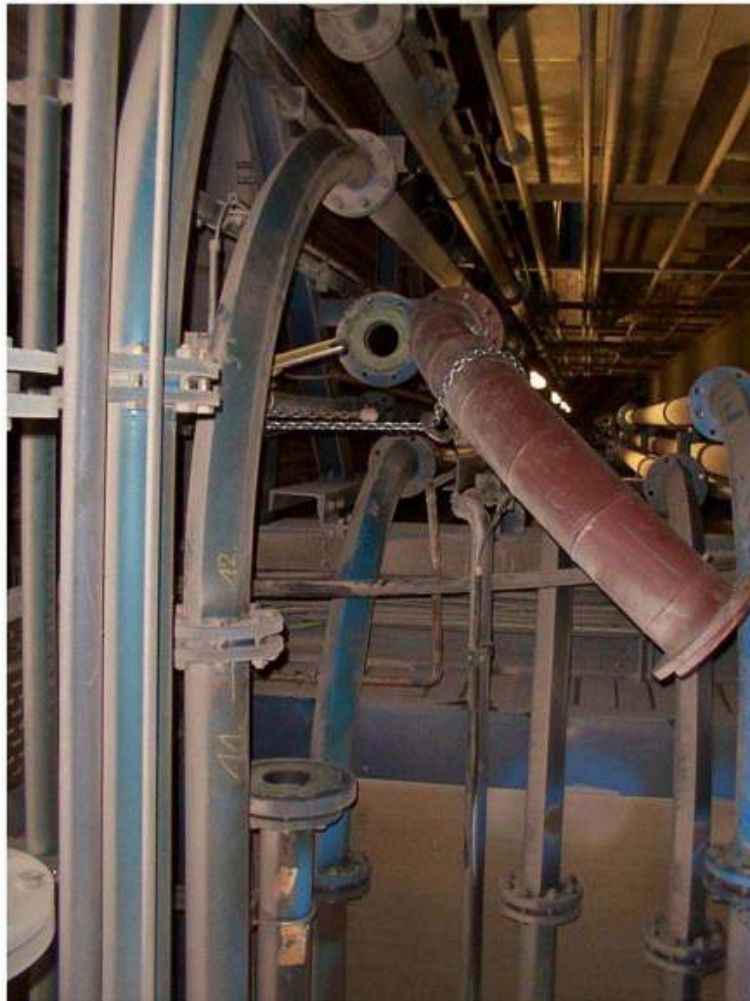
Rohrkrümmer im Einbau: Stahl / Keramik – Verbundsystem
