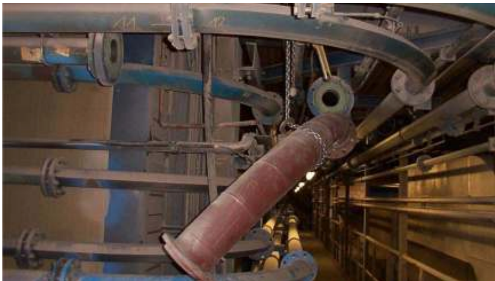
Bild 16: Rohrkrümmer im Einbau: Stahl/Keramik - Verbundsystem
