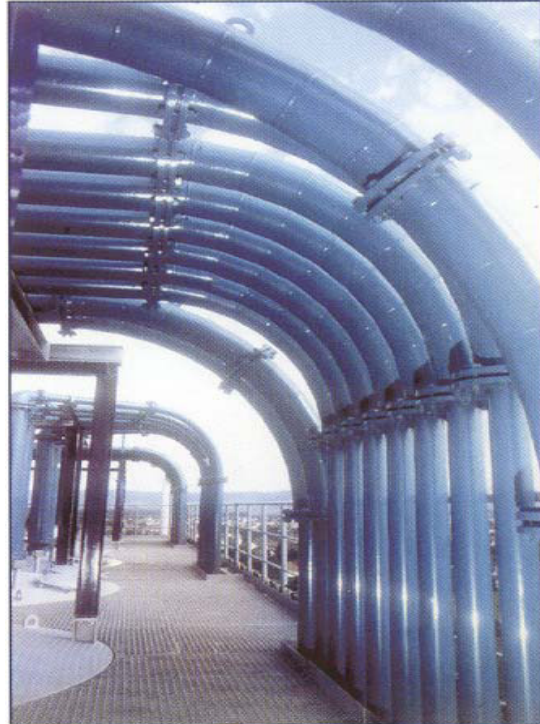
Bild 20 und 21: Siloanlage mit pneumatischer Befüllung
