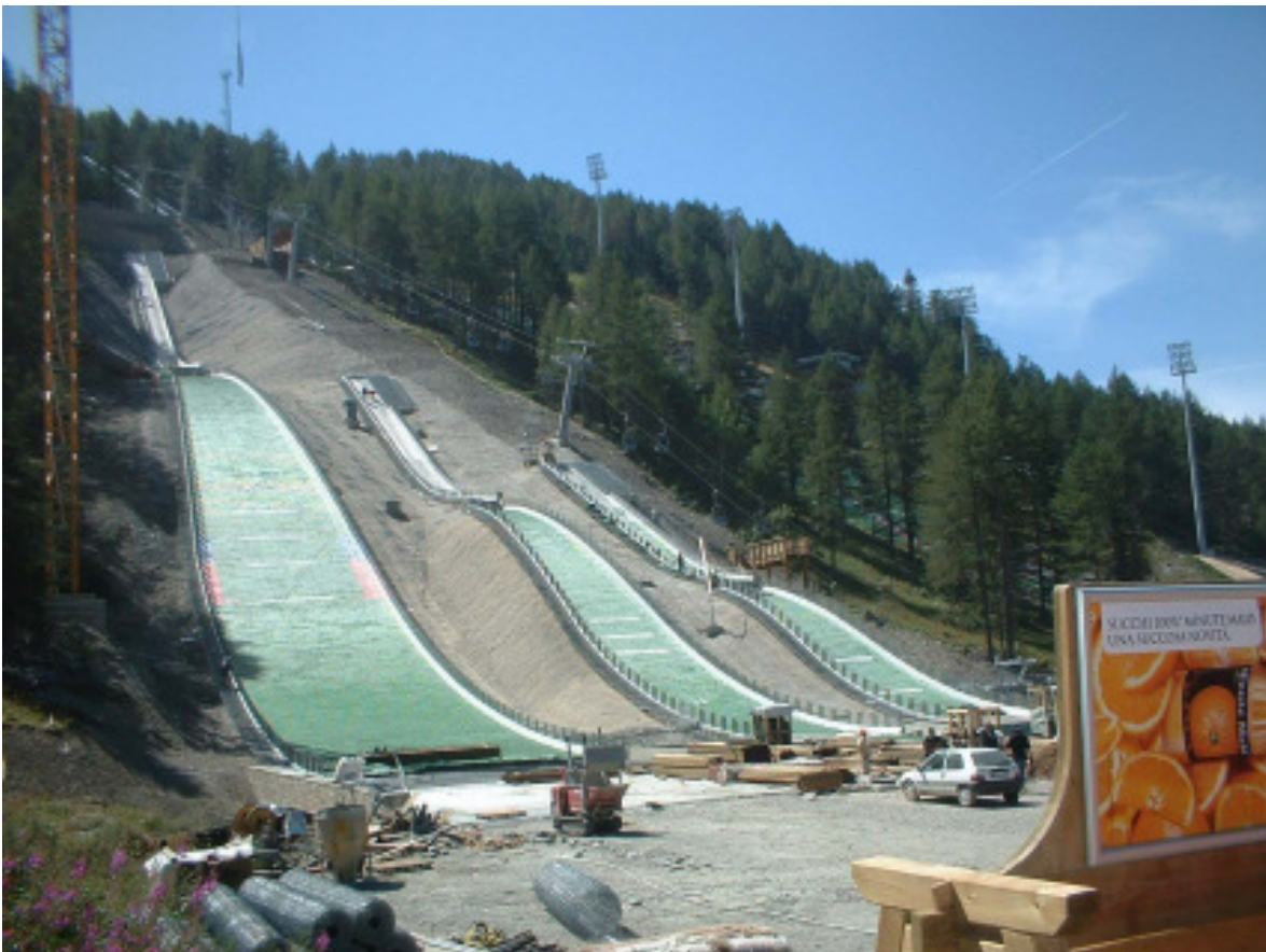
Bild 25: Olympiaschanzen in Turin (im Bau)
