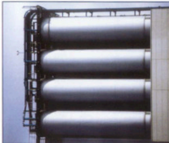
Siloanlage mit pneumatischer Befüllung
