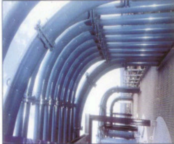
Siloanlage mit pneumatischer Befüllung
