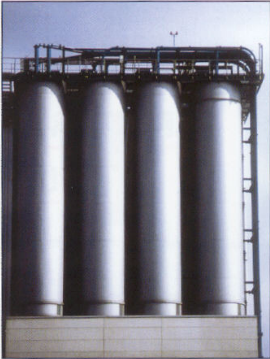
Bild 20 und 21: Siloanlage mit pneumatischer Befüllung
